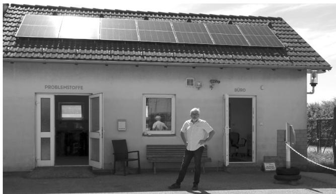
Aufgrund der technischen Gegebenheiten wurden 33 Solarmodule auf einer Fläche von rund 65 m<sup>2</sup> montiert, welche zirka 14.700 Kilowattstunden Sonnenstrom im Jahr liefern! Mit dieser Jahresleistung könnten rund 5 Haushalte mit Strom versorgt werden. Diese Anlage dient zur Deckung des Eigenbedarfes und wird noch 2022 über eine
